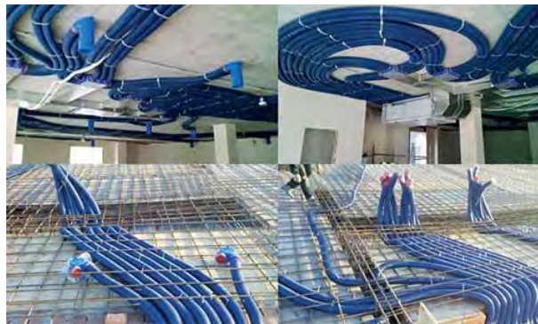
Рис. 2 - Приклад прокладання повітропроводів системи Navy-Flex
