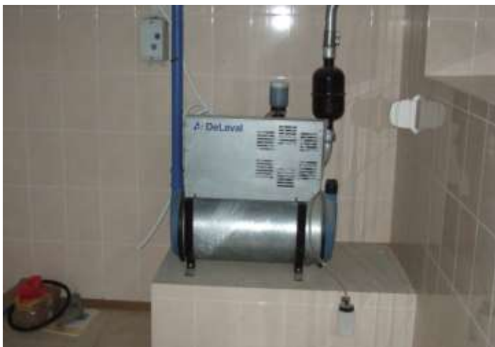
Вакуум-насос фірми "Де-лаваль"
